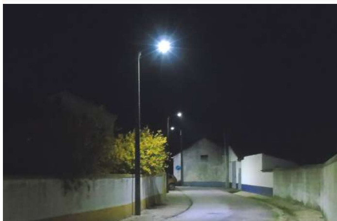
Colocação de Luminárias
