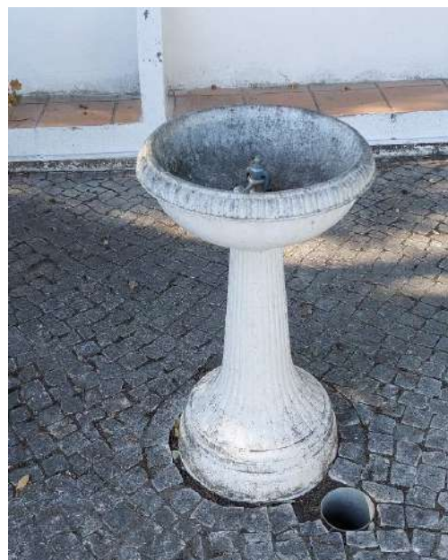
Reparação de Bebedouros de Água
