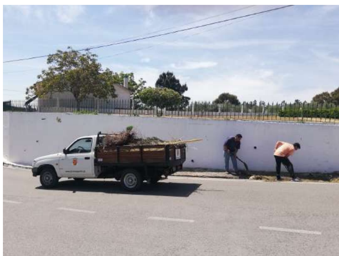
Limpeza de Bermas e Valetas
