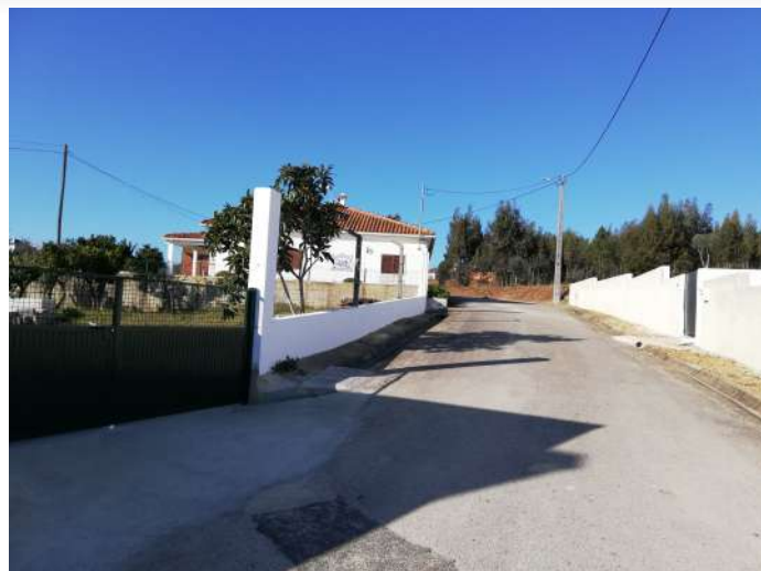
Construção de Valetas
