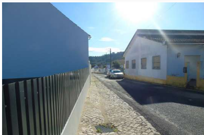
Calçamento de Bermas
